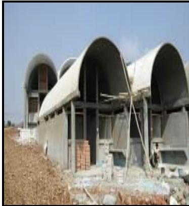
Fig 7.10 Shell roofs (Pune)
